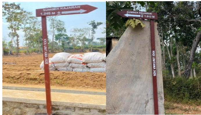
Gambar 2. Pemasangan Papan Penunjuk Arah Menuju Wisuka
