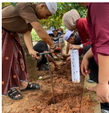
Gambar 2. Peserta santri melakukan praktik pembuatan lubang biopori
