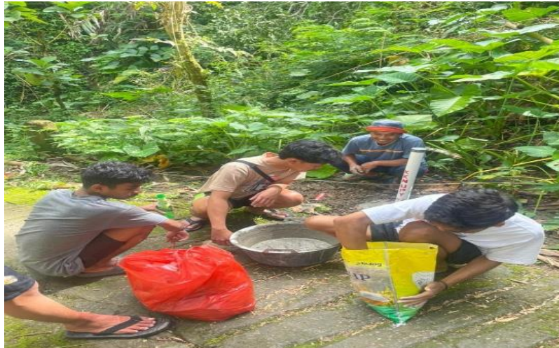
Gambar 10. Proses Pemasangan Reflektor Bersama Warga
