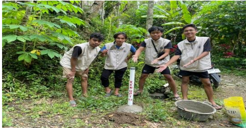
Gambar 11. Dokumentasi Pemasangan Reflektor Jalan
