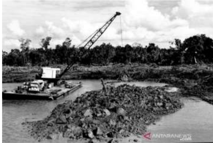
Gambar 7. Aktivitas pengerukan rawa untuk pembangunan fondasi Pelabuhan Dumai tahun 1957
