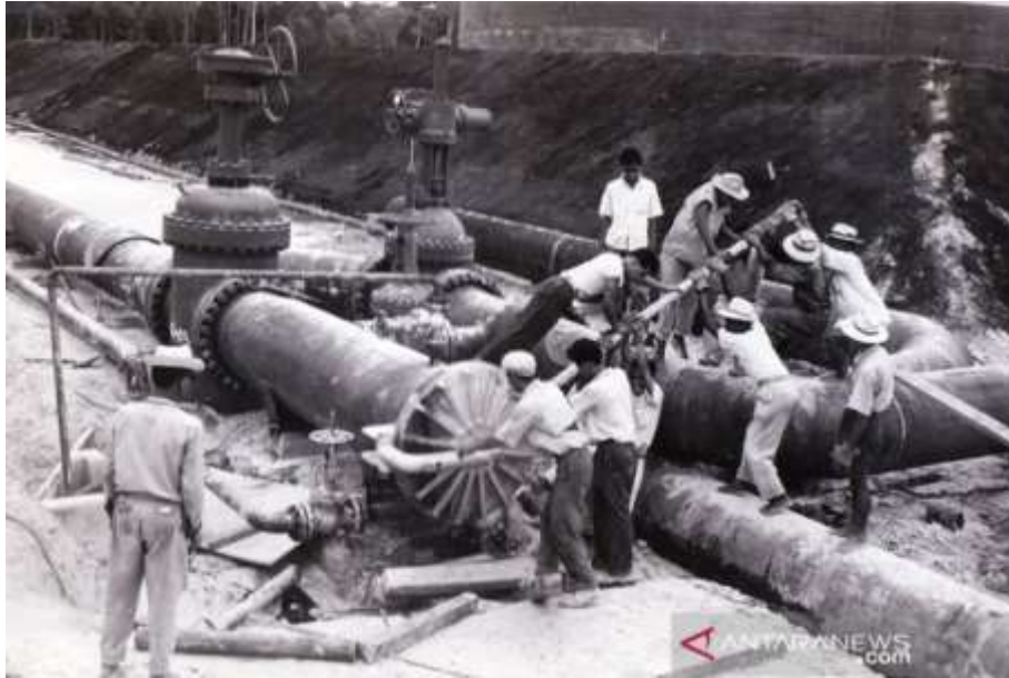
Gambar 4. Pemasangan pipa minyak jalur Duri-Dumai tahun 1958 yang berjalan paralel dengan pembuatan jalan
