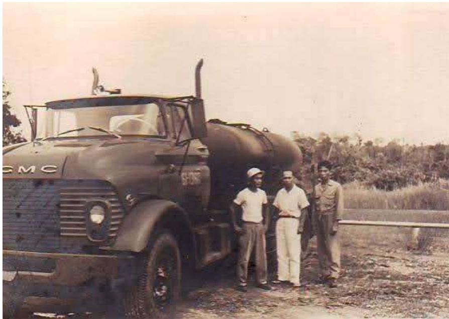
Gambar 5. Metode pengerasan jalan menggunakan siraman minyak mentah ( crude oil )
