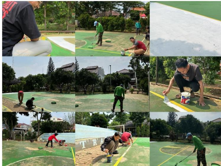
Gambar 2. Pengecatan Lapangan
